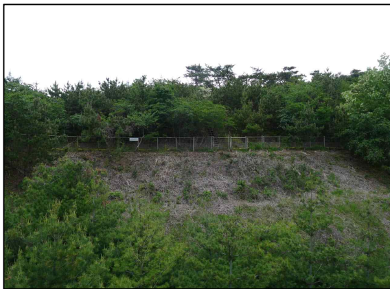
c. 종점부 사면 표면보호공 상태양호
