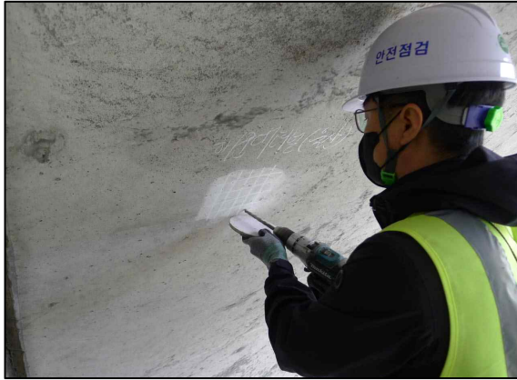
a. 탄산화시험부 부재 천공 현황
