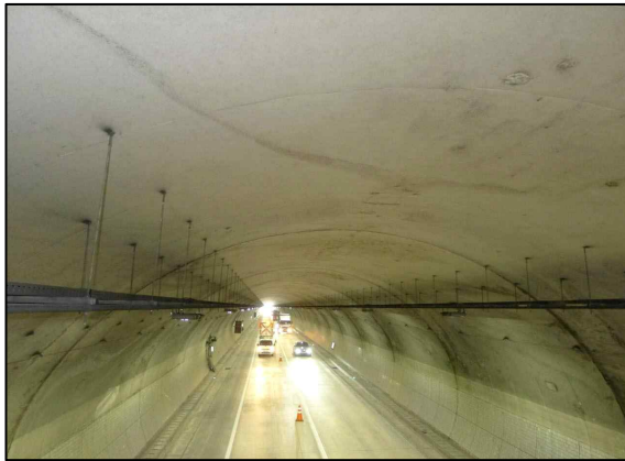
c. 천단부 상태양호(누수 없음)
