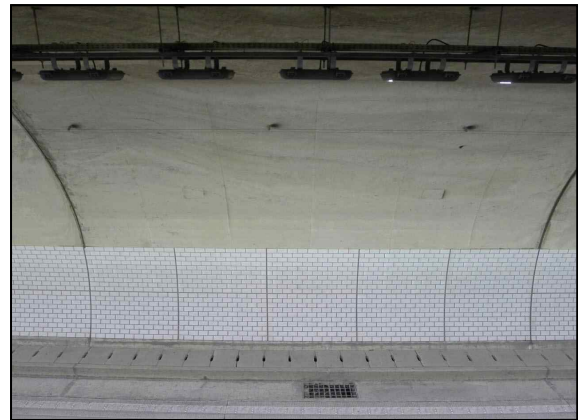
d. 측벽부 타일 시공현황
