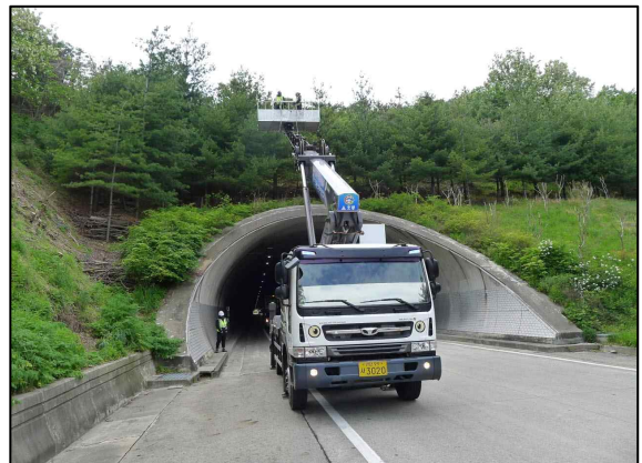
d. 고소작업차량을 이용한 사면 외관조사현황
