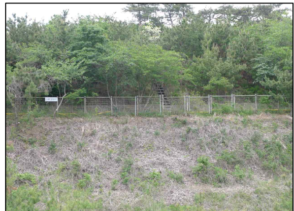
b. 사면 내 점검계단 설치현황
