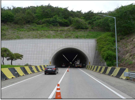
a. 시점 갭문 면벽 상태양호
