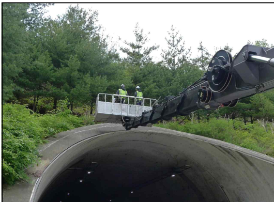
c. 고소작업차량을 이용한 갱구부 외관조사현황
