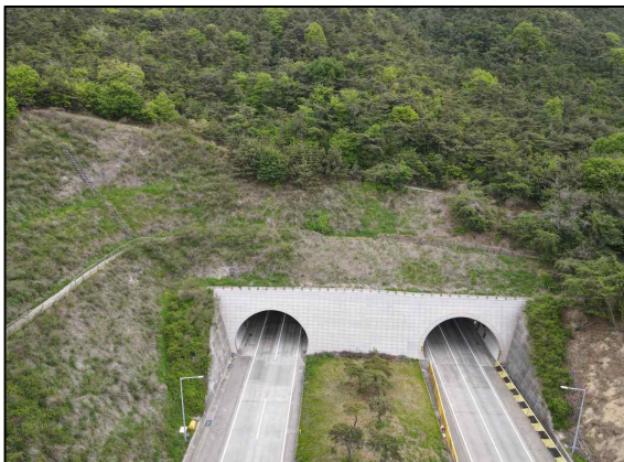
a. 시점부 사면 전경
