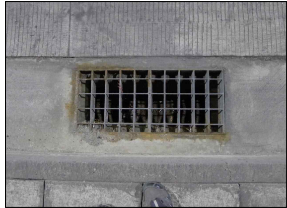
b. 배수시설 집수구 전경
