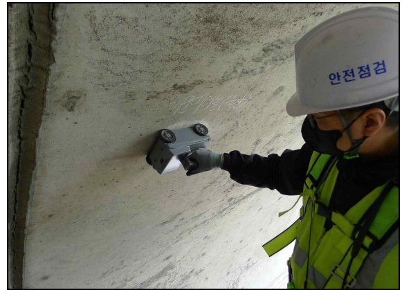
d. 탄산화시험부 피복두께 측정현황
