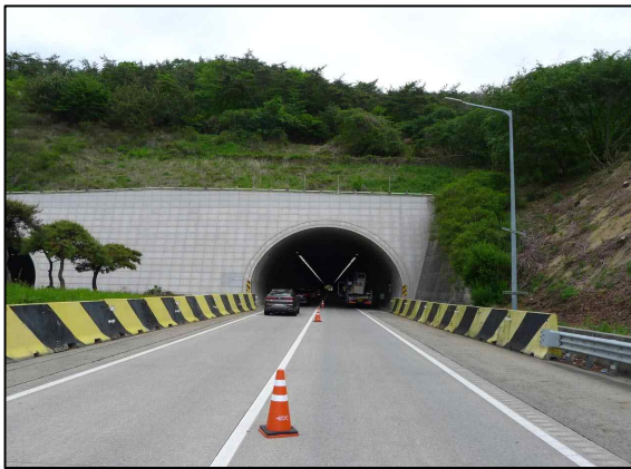
a. 시점부 갱문(면벽식) 전경
