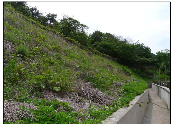
b. 시점부 사면 표면보호공 상태양호
