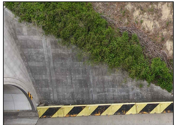
b. 갱구부 옹벽(시점 우측) 상태양호②
