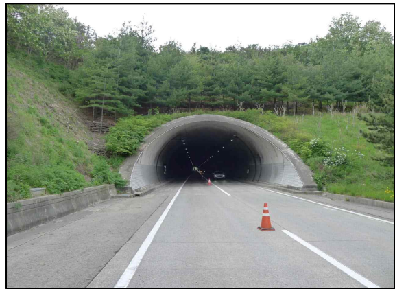
b. 종점부 갱문(원통절개식) 전경
