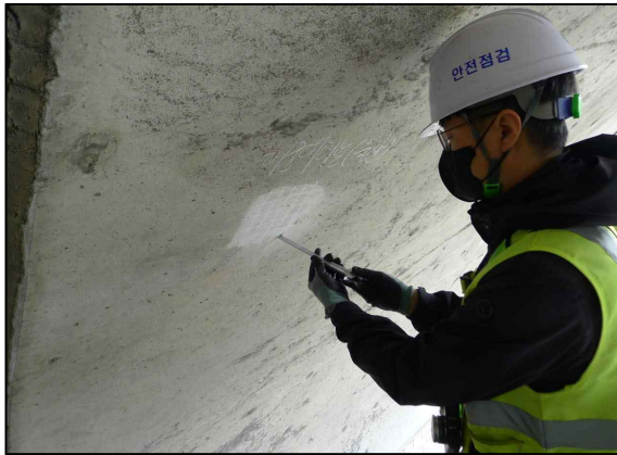
c. 탄산화깊이 측정현황
