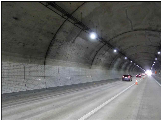
c. 콘크리트 라이닝(측벽부) 전경
