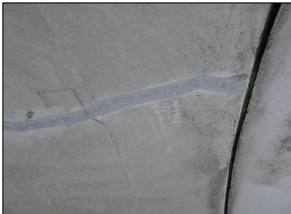
m. 천단부 S72 균열 보수현황
