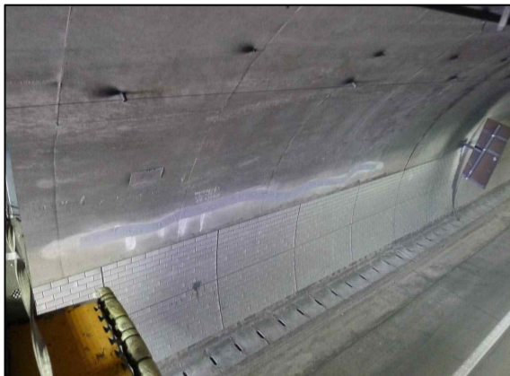
m. 측벽부 S72 균열 보수현황
