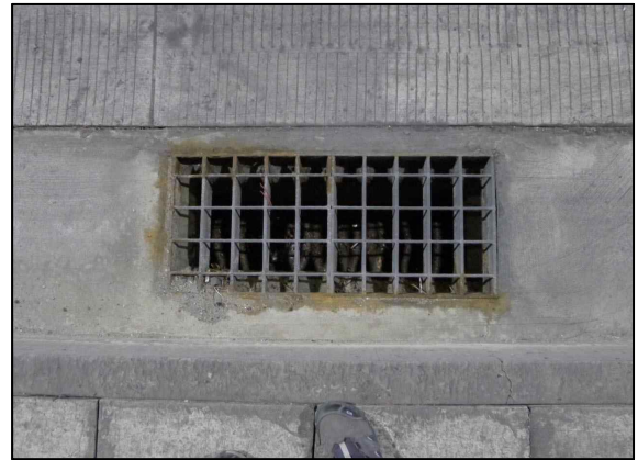
d. 배수시설 상태양호
